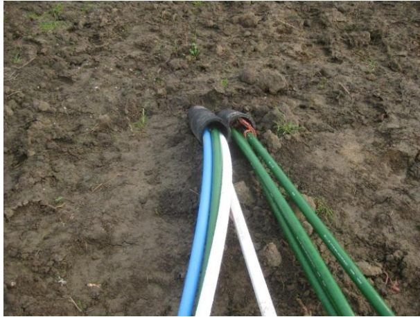
Fig 5 Het intredepunt van de Rijnboring in de uiterwaarden van Millingen en het eindpunt in Herwen. Daartussen ligt nog een boring onder de Oude Waal en een 2,5 km lang tracé door natuurgebied De Byland. De witte buizen zijn voor TeleMANN. Drie groene buizen zijn voor UPC, nog een groene buis is voor Alliander en de blauwe buis is voor de lokale steenfabriek.
