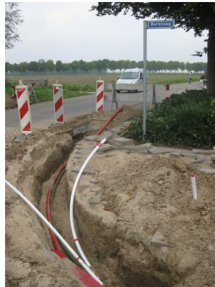
Fig 5 Het intredepunt van de Rijnboring in de uiterwaarden van Millingen en het eindpunt in Herwen. Daartussen ligt nog een boring onder de Oude Waal en een 2,5 km lang tracé door natuurgebied De Byland. De witte buizen zijn voor TeleMANN. Drie groene buizen zijn voor UPC, nog een groene buis is voor Alliander en de blauwe buis is voor de lokale steenfabriek.
